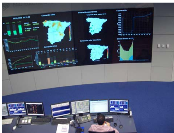
再生可能エネルギーコントロールセンター スクリーンにはCO 2 排出量のリアルデータも映し出される(右下)
