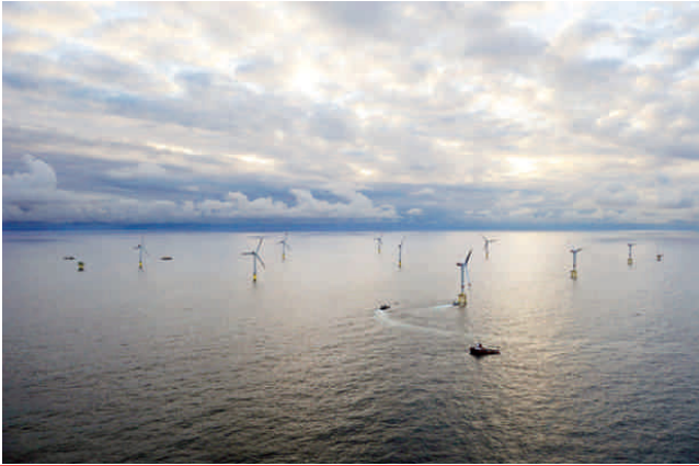
風力による大小の負荷、打ち寄せる波、天候変化など過酷な条件の下で工事、運用される海上設置の風力発電設備は陸上のものと比較して多くの要求や困難が生じます 写真: Alpha Ventus
