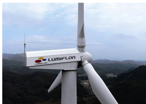
写真8 株式会社北拓様 南伊豆発電所塔とブレードに試験塗装中です。
