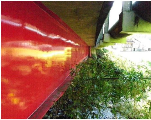
写真 2 25年を経過のふっ素樹脂塗装橋梁
