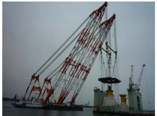
図 2.7 重力式基礎をフローティングドックに積み込む作業
