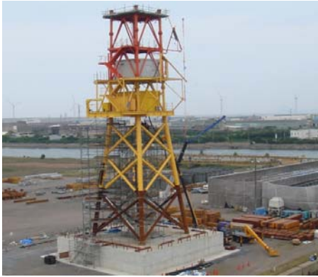
図 2.9 洋上風況観測タワーの基礎及びタワー下部
