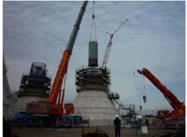
図 2.6 製作中の重力式基礎
