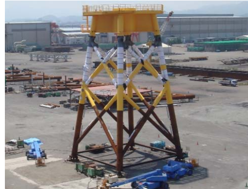
図 2.10 洋上風車の基礎(ジャケット部)
