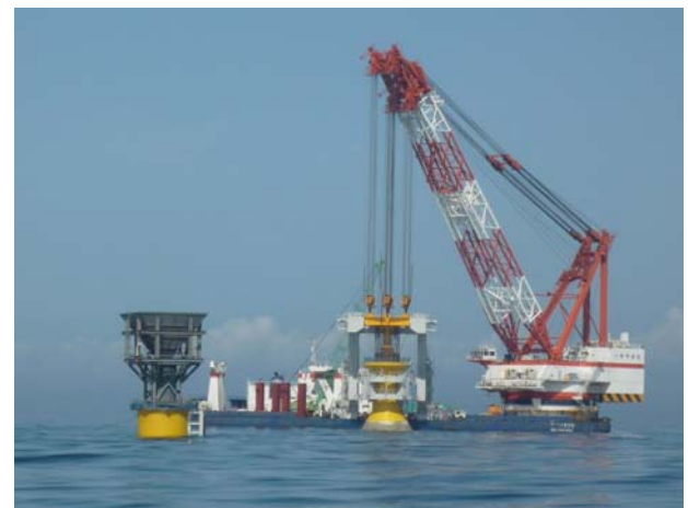
図 2.8 設置後の重力式基礎 (左：洋上風況観測タワー、右：洋上風車)
