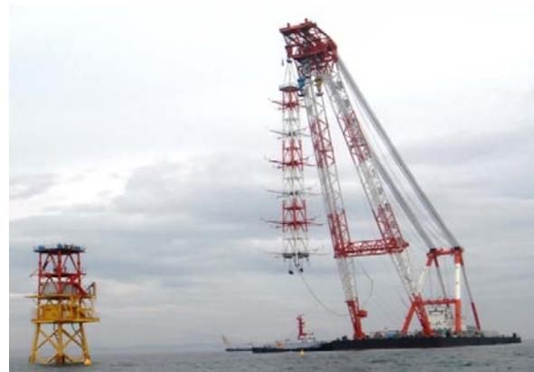
図 2.12 洋上風況観測タワーの基礎及び下部へ上部を接続する作業
