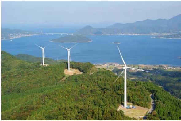
図3 高台への風力発電施設の設置例 (12)
