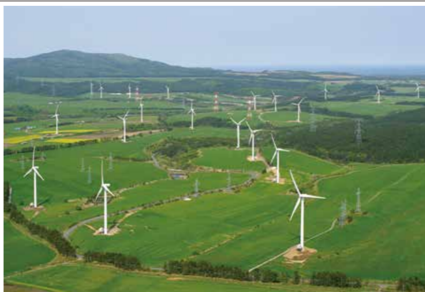
青森県六ヶ所村の風力発電群。日本の風力発電は陸上で礎が築かれ、さらに洋上へと大きく羽ばたいています
