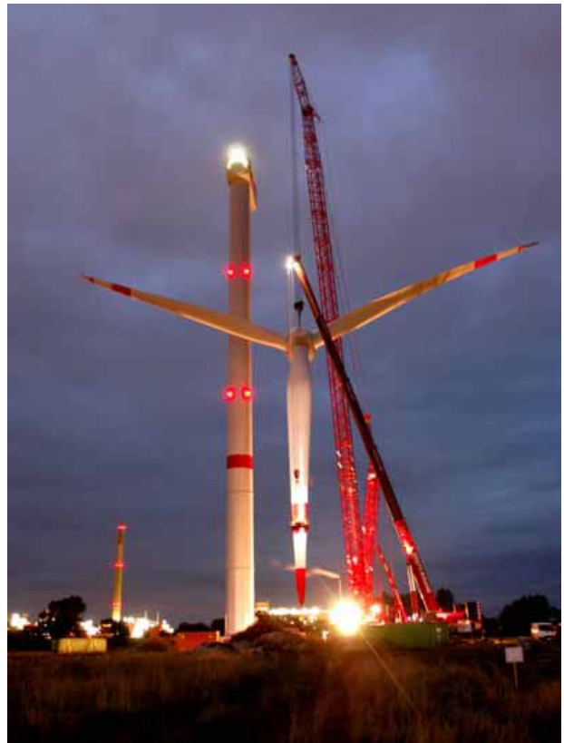
10月1日夜、据付中。ローター重量 120 t、ハブ高さ 120m、クレーン吊上高さ 136m。
