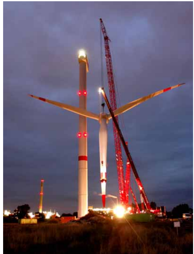
10月1日夜、据付中。ローター重量 120 t、ハブ高さ 120m、クレーン吊上高さ 136m。
