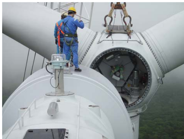
ブレード取付状況
