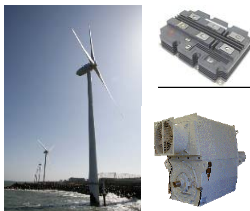
注：略語説明 IGBT (Insulated Gate Bipolar Transistor)、SUBARU80/2.0 (ブレード直径 80m、出力 2,000kW のダウンウィンド 2MW 機量産機の型式名) 図 1 ダウンウィンド 2MW 機の量産機 (SUBARU80/2.0) 及び発電システム
