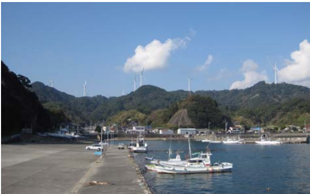
2010 年 4 月に運転開始した、石廊崎風力発電所
