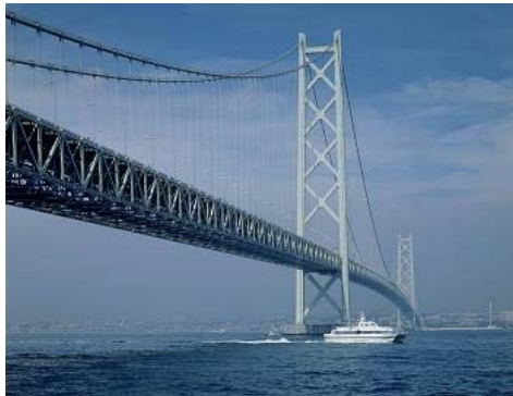
写真 4 明石海峡大橋 メンテナンスコスト低減 (LCC 低減) ふっ素樹脂塗装は 1990 年より本州四国連絡橋公団により採用され、しまなみ海道など新設
