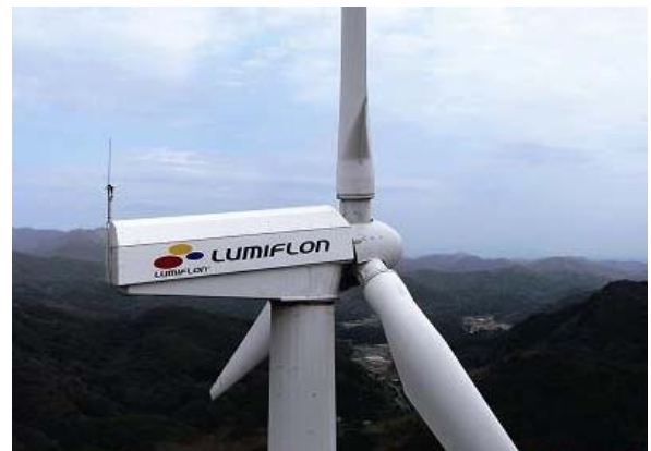
写真 5 株式会社北拓様 南伊豆発電所塔とブレードに試験塗装中です。
