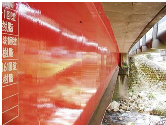
写真 1 塗装後 21 年を経過した塗料用フッ素樹脂ルミフロンの塗膜の橋梁 初期の色つやがほとんど変わっていません。
