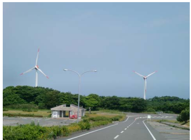
「千畳敷」より油谷風力発電所を望む
