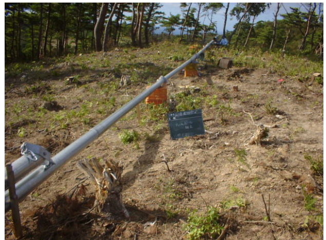
風況調査タワー工事状況
