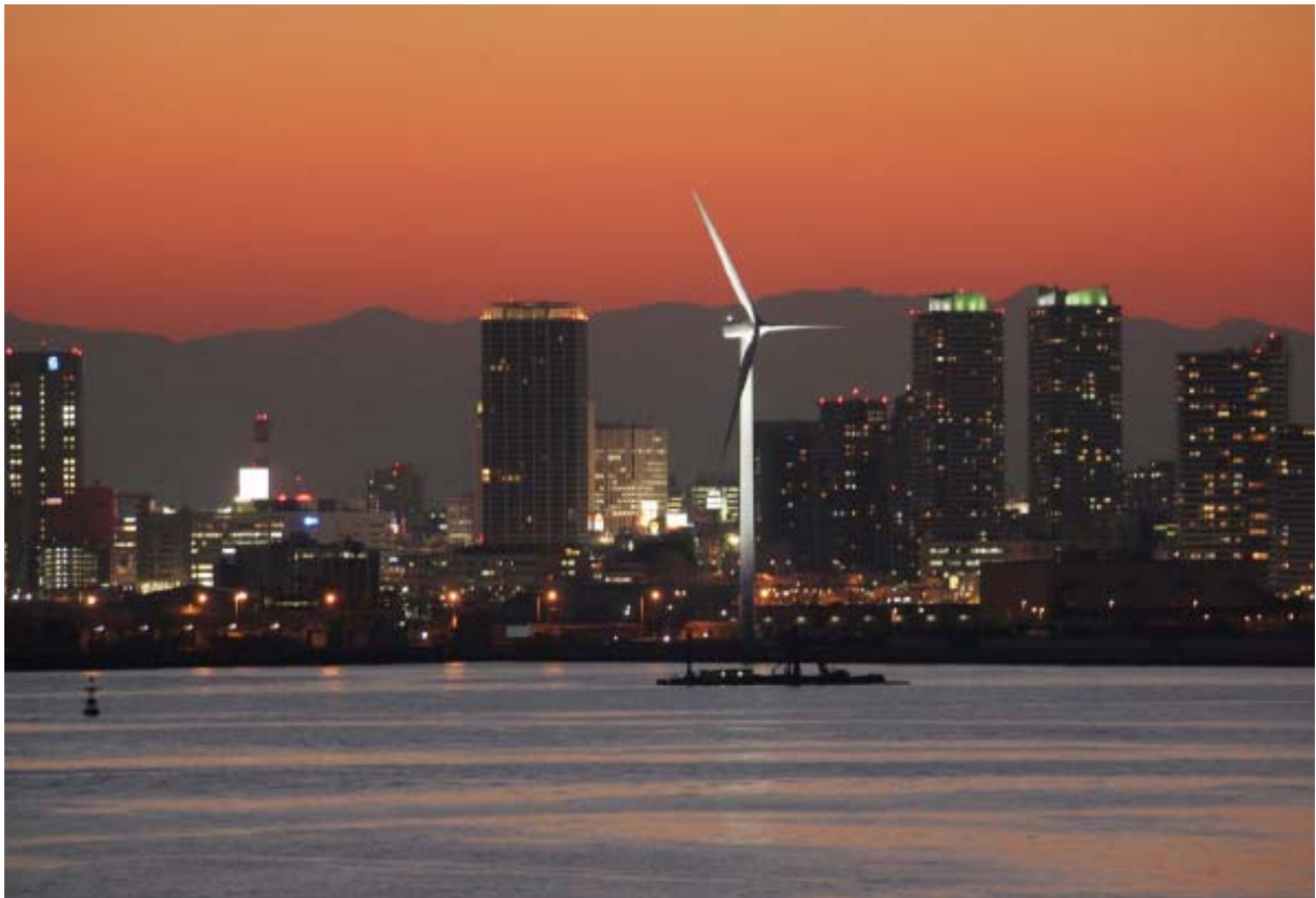
横浜市風力発電所「ハマウイング」
