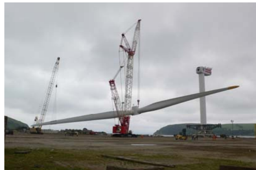
英国の風力発電設置現場
