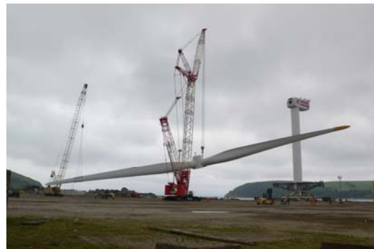
英国の風力発電設置現場
