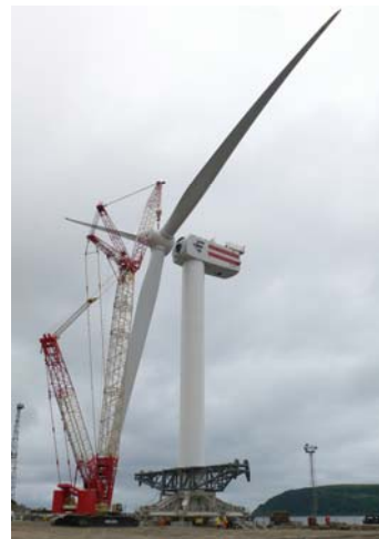
約 135t のブレードを取り付ける SL6000J-500
