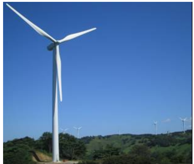
里美牧場風力発電所
