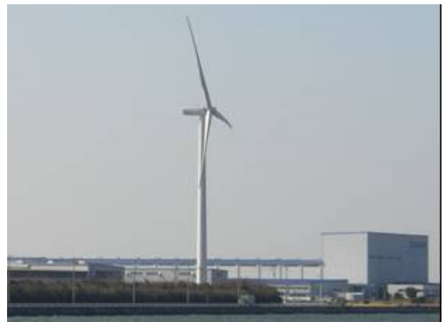
御津風力発電所
