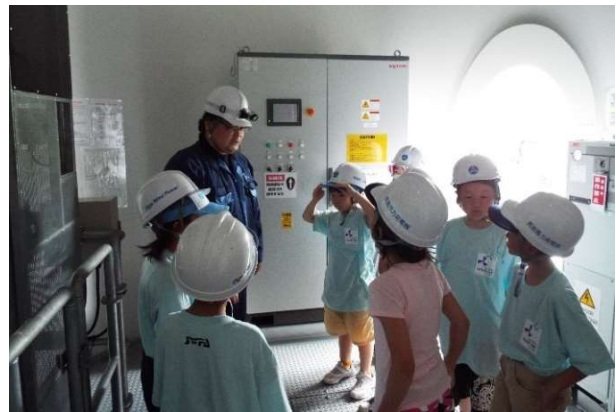
初めてのタワー内部
