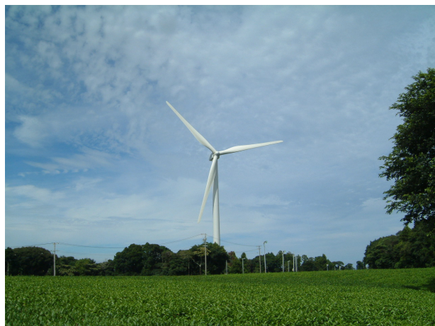
【落居風力発電所】
