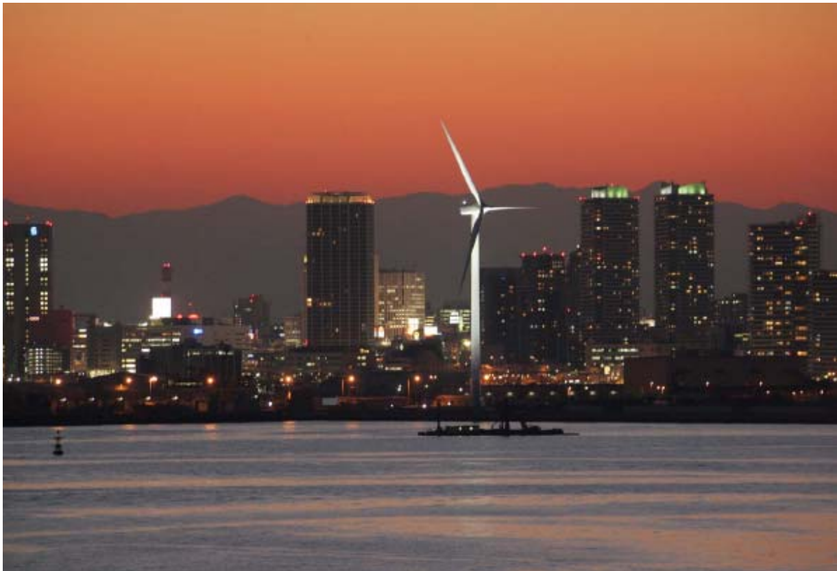
横浜市風力発電所「ハマウイング」
