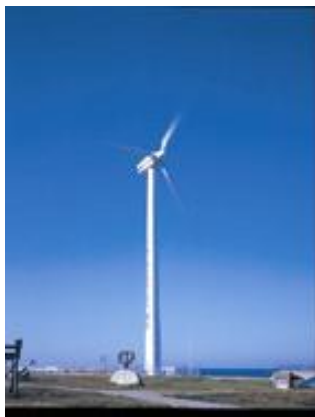
能生海洋公園（新潟県） V29-225/50kW 1基 （平成11年9月運開）
