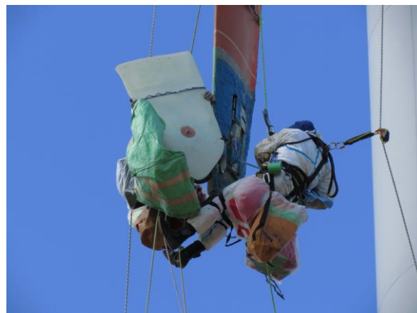
先端落雷損傷の復旧工事
