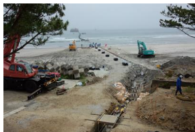
海底ケーブル施工※
