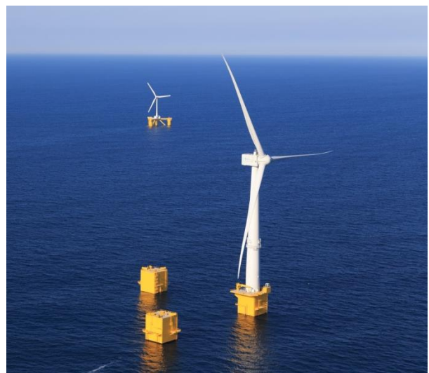
福島復興・浮体式洋上ウインドファーム 実証研究事業
