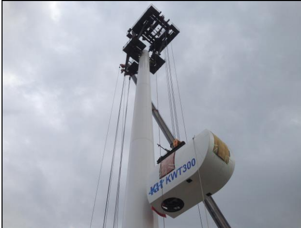
富津工場 2 号機建設時 ワイヤーによるナセル吊り上げの様子
