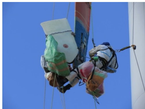
参考写真-ブレード補修状況
