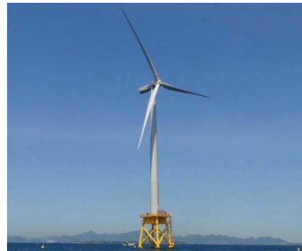
福岡県北九州市沖 2.0MW×1基 (NEDO 実証研究)
