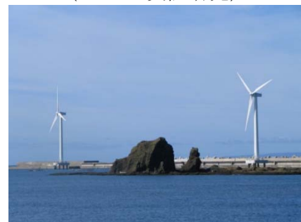
北海道瀬棚港 600kW×2基
