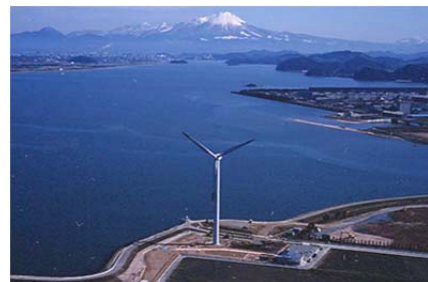
島根県安来市 600kW×1基(五洋が事業者) その他にも多数の実績を有しています。
