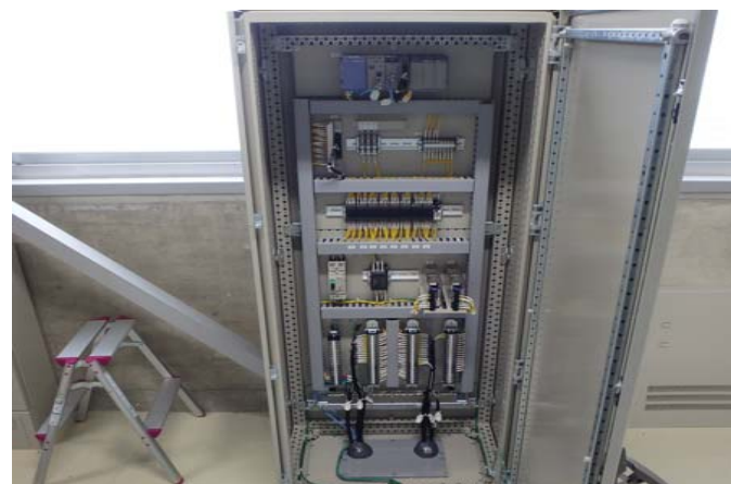
出力制御盤(CTL) 設置状況
