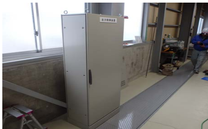
出力制御盤(CTL) 設置状況
