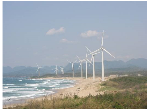
島根県江津市 2MW×11基
