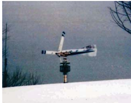
北海道M町10kW風力発電機(1997年撮影)
