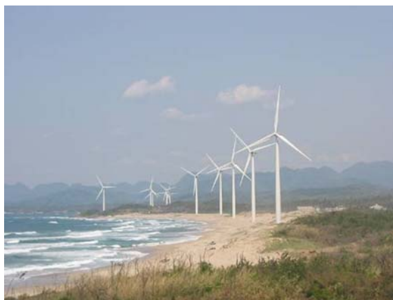
島根県江津市 2MW×11基
