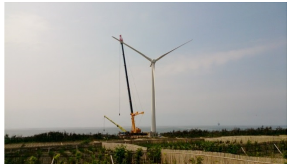
完成間近の胎内風力発電所 (2014 年 6 月)
