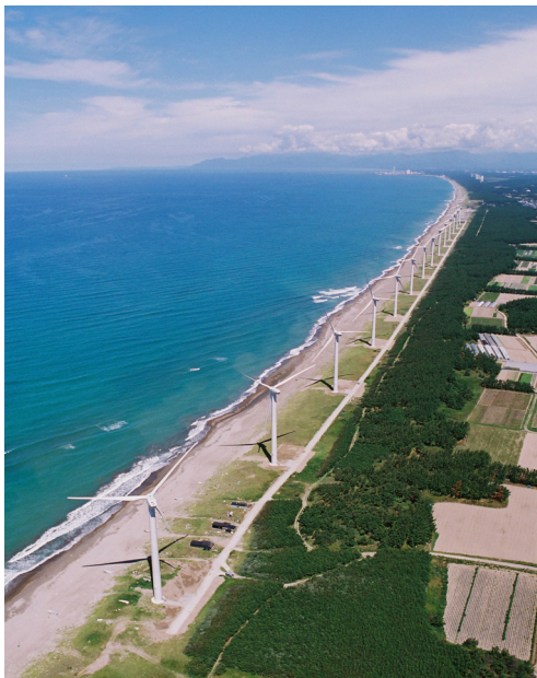
写真1 八竜風力発電所全景
