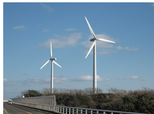
宮川風力発電所
