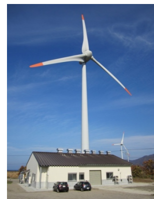
図3 蓄電池格納庫
