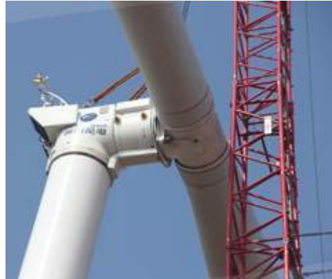
図10 明陽 Mingyang の2枚翼風車
