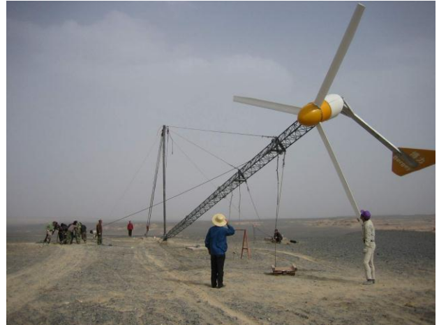
人力ウインチで風車を据付ける
