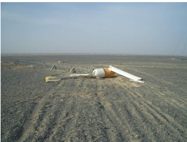
支線の固定方法に問題があり、強風で倒壊した風車
