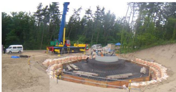
写真3 鉄筋配筋作業状況
