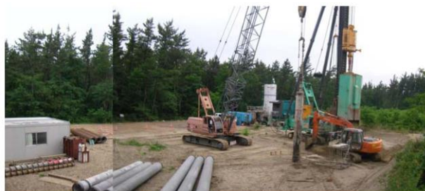
写真2 基礎杭打ち作業状況
