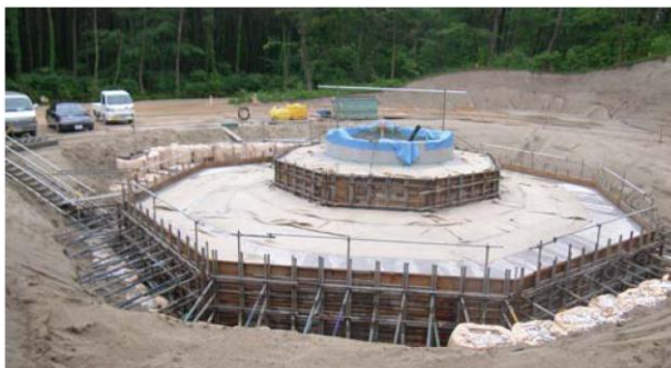
写真4 コンクリート打設養生作業状況
