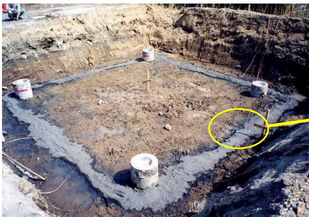
写真1 鉄塔基礎（構造体接地）を有効活用するための補助接地電極（サンフレックスS工法）
