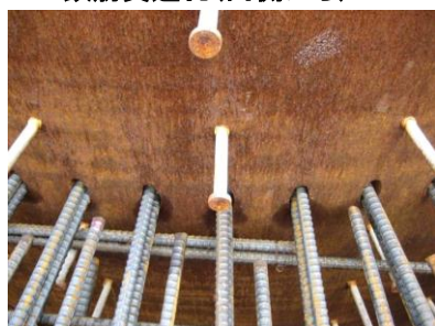
鉄筋貫通状況(外側から)
