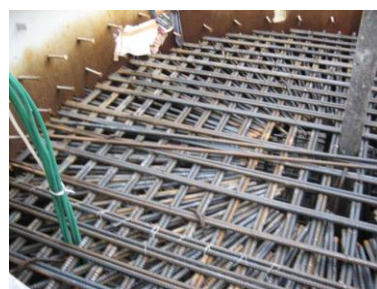
貫通鉄筋状況(リング内側)
