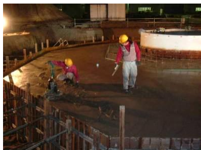
コンクリート均し 2回目以降
