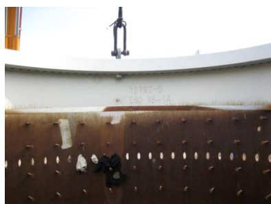
鉄筋貫通孔(内側から)
