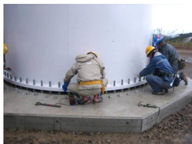
写真左 アンカーボルト 外フランジ接合
