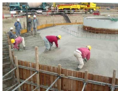
コンクリート均し 1回目
