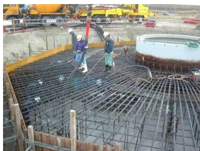
フーチング打設状況
