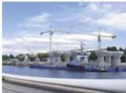
出典:HOCHTIEF Construction AG(2007)
