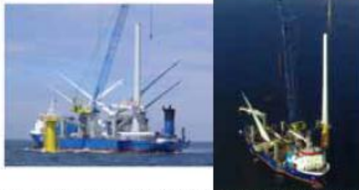
特殊船(MV SEA POWER:セミジャッキアップクレーン)による運搬と施工/モノパイルタワー(黄色の支柱)/ブレード(2枚翼) 出典: van Kuik(2006)/A2SEA HP
