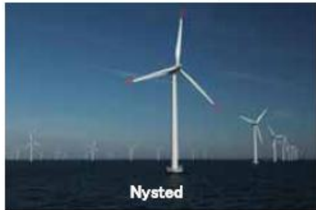
国名:デンマーク、発電設備: 165.6MW(2.3MW×72基)、基礎構造:重力式、水深:6-10m、離岸距離:10km、運転年月:2003.12 (出典:www.nystedwindfarm.com)
