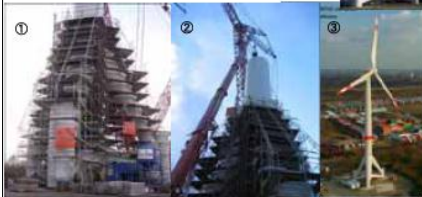
Multibrid M5000の実証試験場(ドイツ プレーメルハーフェン) ①・②:組立風景(重量:600t, 2006.11.24撮影) ③完成写真(Schulz,2007)
