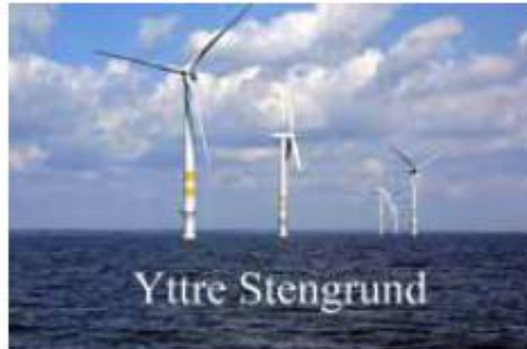
国名: スウェーデン、発電設備: 10MW (2MW × 5基)、基礎構造: モノパイル式、水深: 6-10m、離岸距離: 5km、運開年月: 2001.7 (出典: Yttre Stengrund HP)
