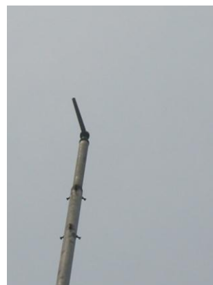
図6 冬季雷によって避雷針が変形した例
